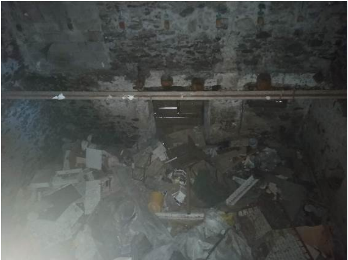
Solaio piano primo crollato
