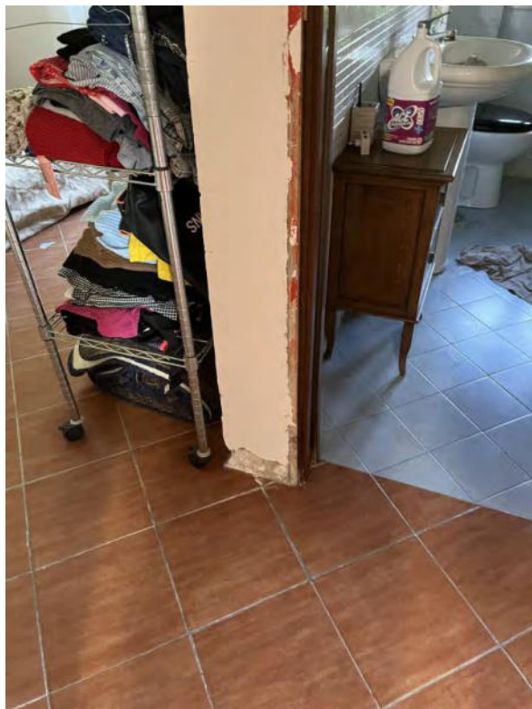
Piano terra – pareti degradate in corrispondenza del servizio igienico
