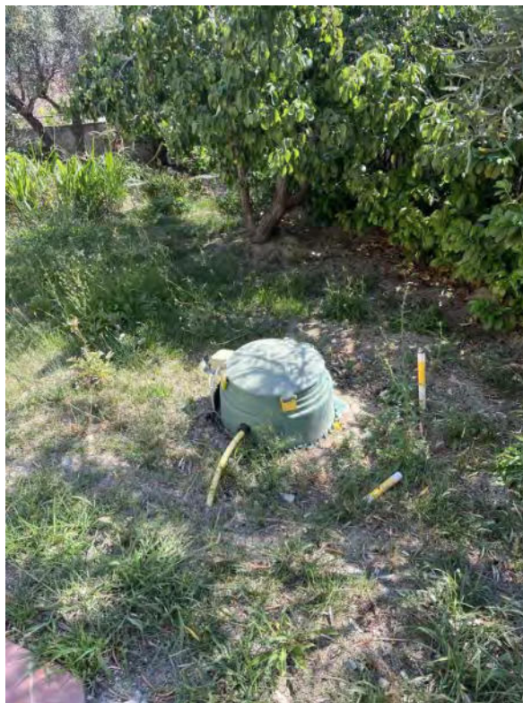
serbatoio gpl interrato
