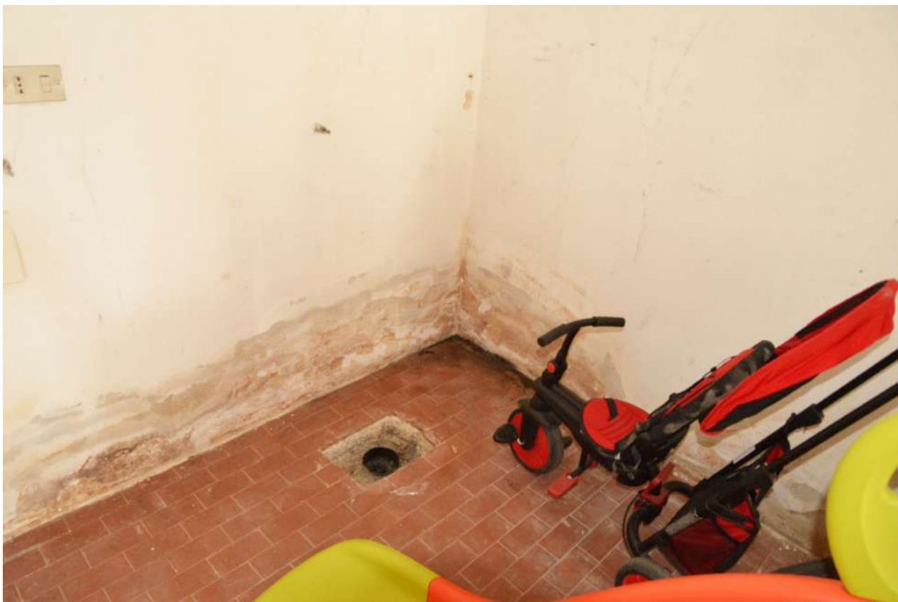
foto n. 35 – particolare infiltrazioni sub 6 garage
