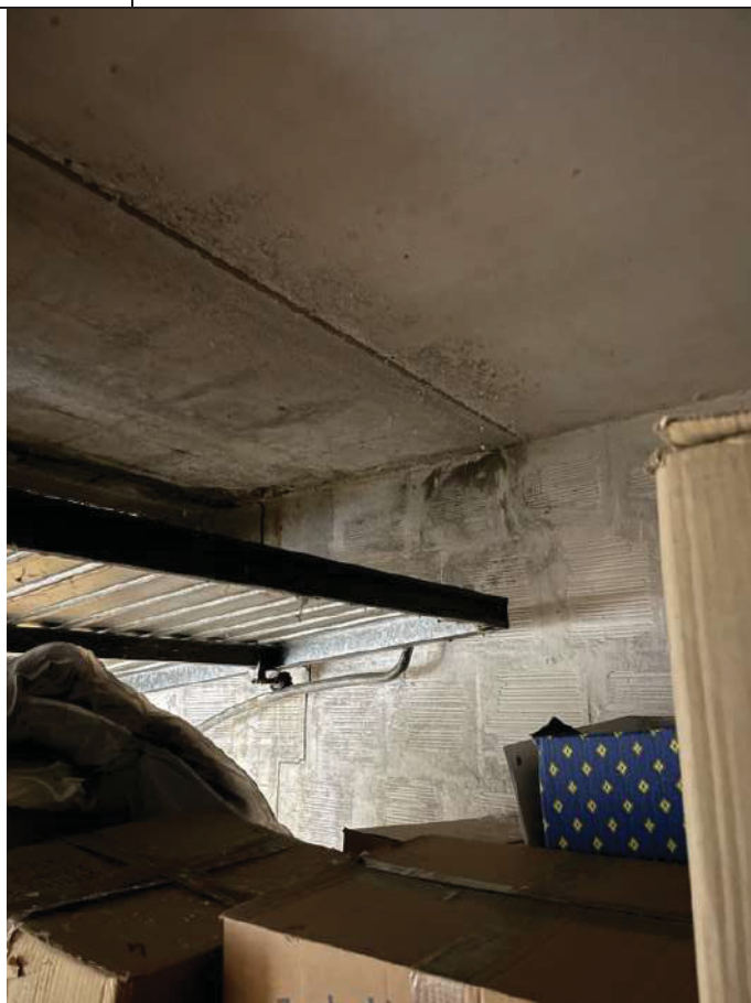
Interno box presenza di infiltrazioni
