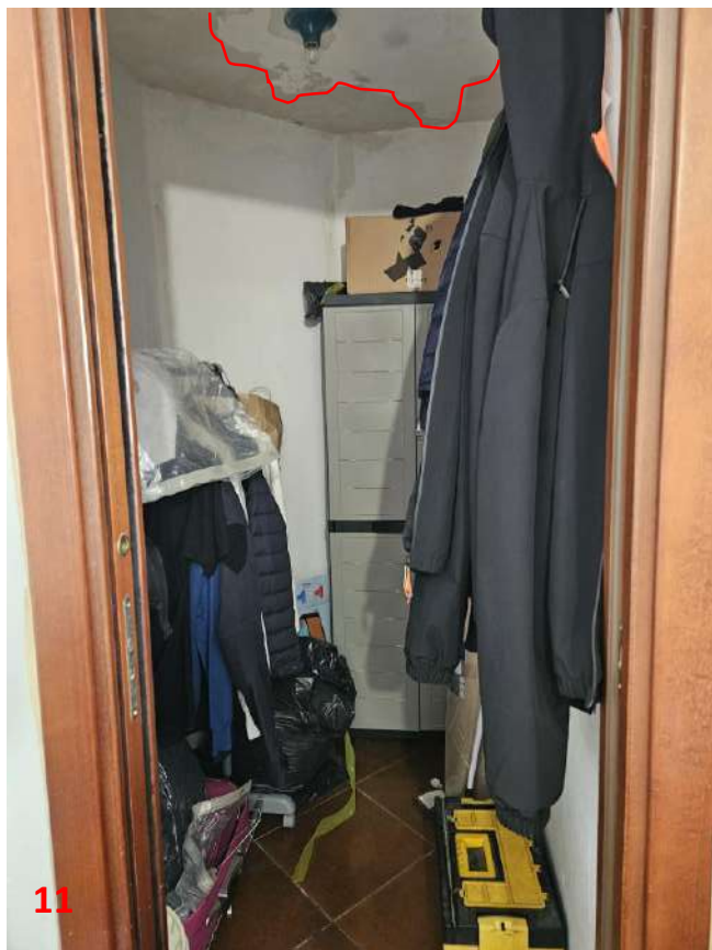
Fig.re 9-10-11 Particolare servizio igienico e ripostiglio (evidenziazione delle infiltrazioni all'intradosso del solaio)
