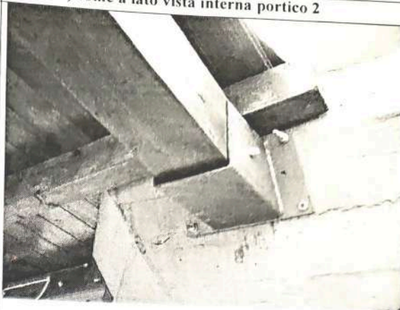
Ril. n° 6) vista sistema collegamento copertura portici su pareti verticali
