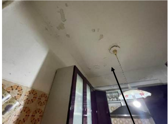
Fig. n. 17 Particolari delle macchie di umidità
