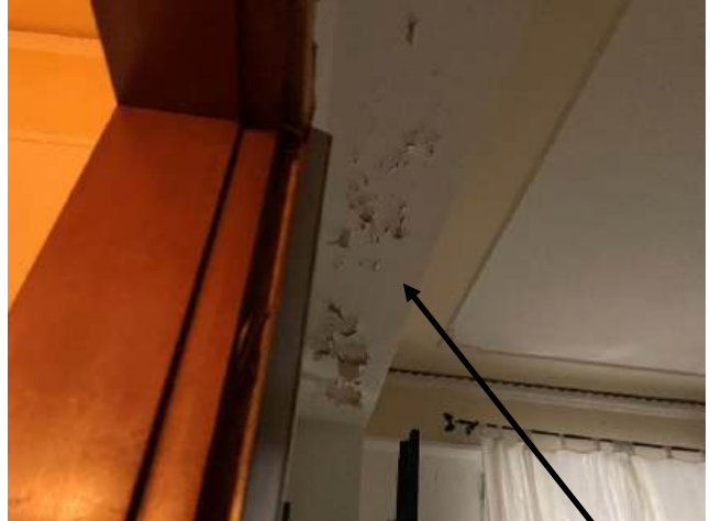
Fig. n. 15 Particolari delle macchie di umidità
