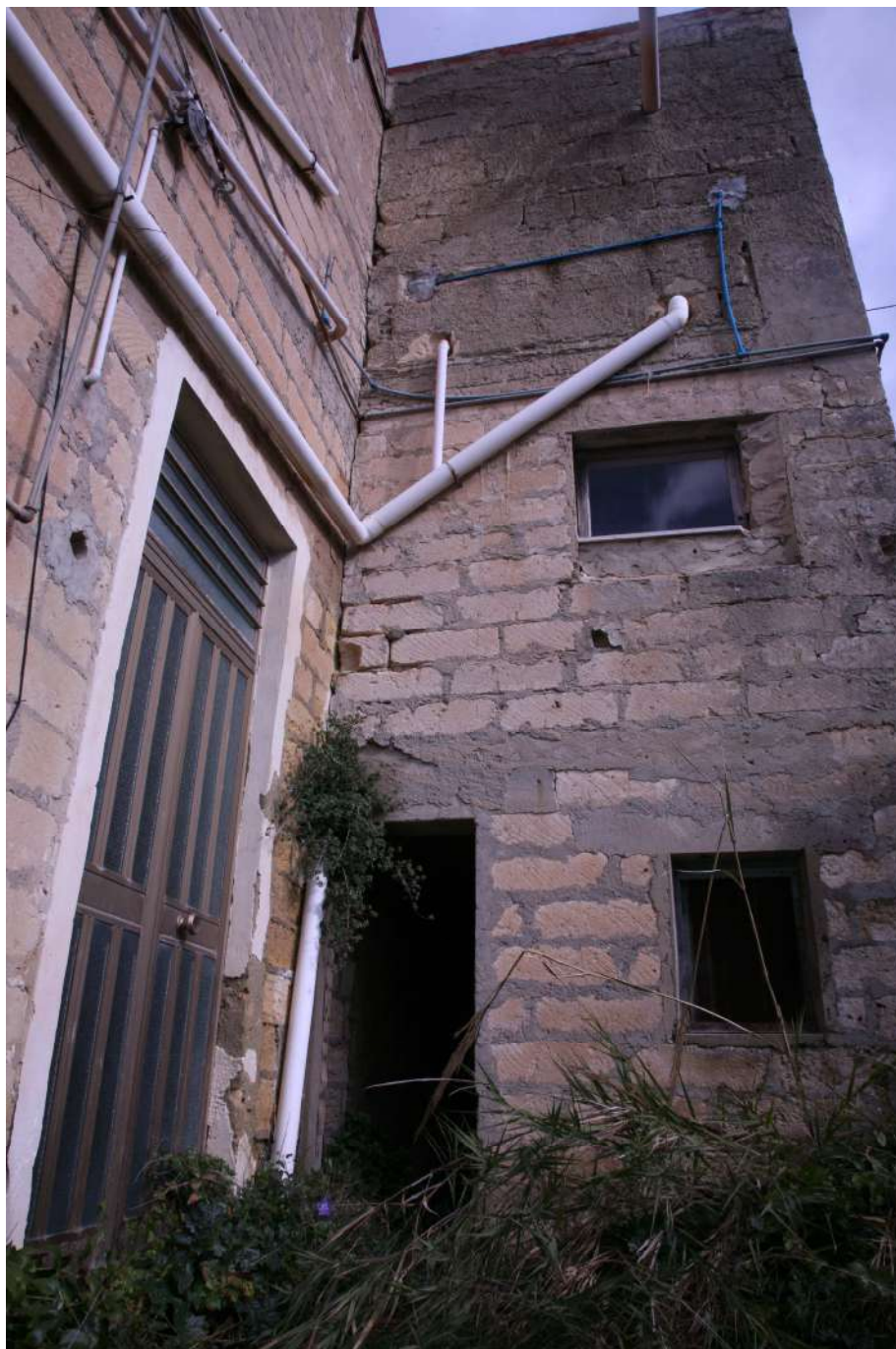
FOTO 12 : Particolare corpo B e corpo A – si evidenzia il distacco del corpo B, con rotazione in senso orario.
