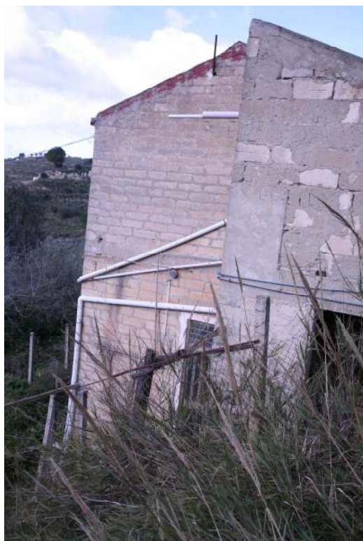
FOTO 6: Particolare prospetto Est corpo A e corpo B- Si evidenzia la mancanza di cordolo in c.a.
