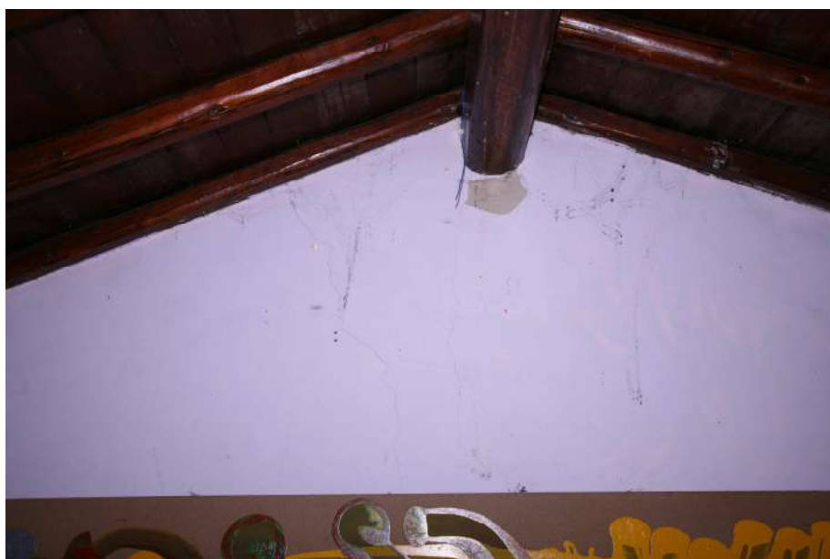
FOTO 21: Particolare fessura del timpano, su cui poggia la trave di colmo in legno.
