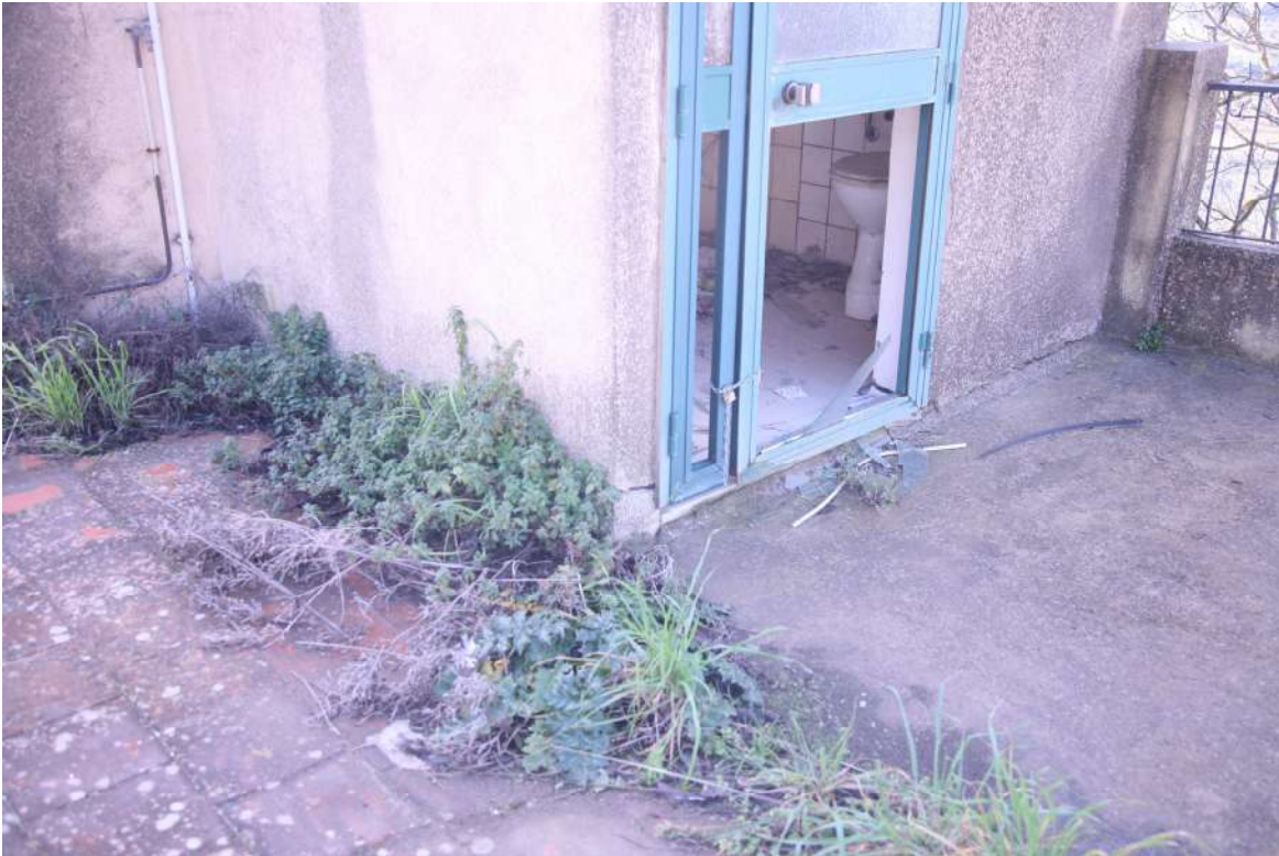
FOTO 34 : Particolare crescita della erbe sulla fessurazione dello spiazzale e muro esterno del corpo B che risulta con connesso con una adeguata fondazione. Si evince la rottura al piano di appoggio del muro.
