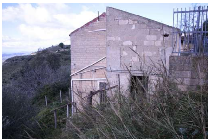
FOTO 7: Particolare prospetto Est- si evidenzia lo sfalsamento dei solai dei Corpi A e B.
