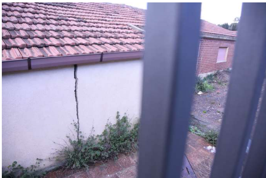
FOTO 3: Particolare Fessurazione corpo B.
