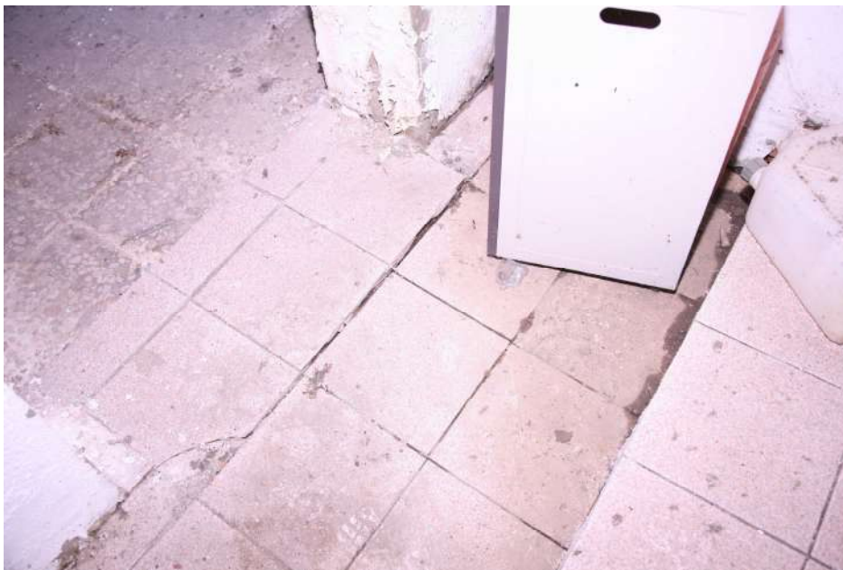
FOTO 19 : Particolare cattivo collegamento solaio corpo A e corpo B.
