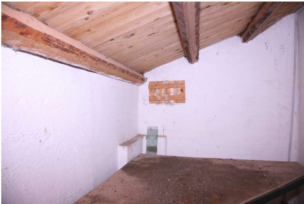
FOTO 24: Particolare delle travi in legno della copertura del corpo B- Si evidenzia la mancanza di cordolo in c.a.
