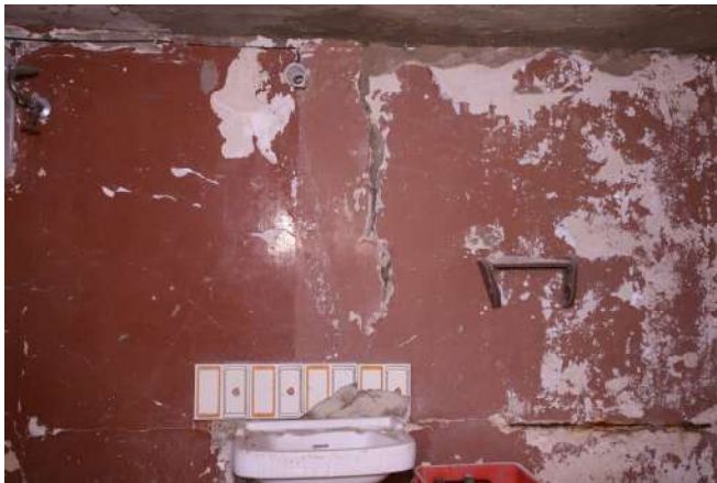
FOTO 11 : Particolare vano interno del corpo B – Si evidenzia efflorescenza dovuta a infiltrazione d'acqua dal terrapieno.
