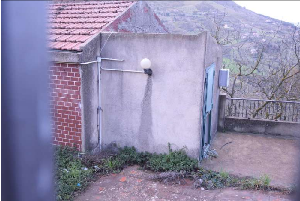
FOTO 32 : Particolare corpo C – si evince come la struttura muraria sia appoggiato senza connessione al corpo A, e sia mancante di cordolo in c.a., con scarsa o inesistente costituzione di fondazione.
