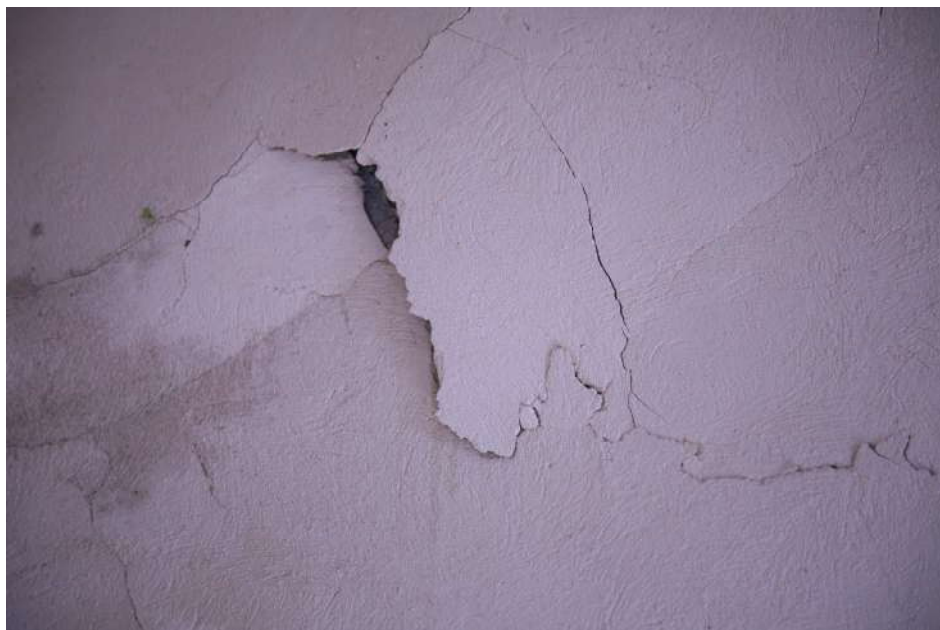
FOTO 25: Particolare dello stato fessurativo del piano terra.
