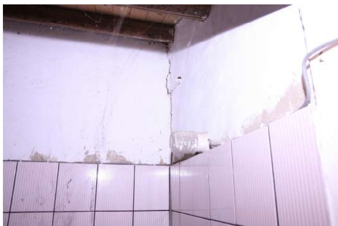
FOTO 16: Particolare fessura parte sud del corpo B
