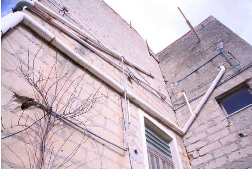
FOTO 14 : Particolare distacco tra i corpo A e B.
