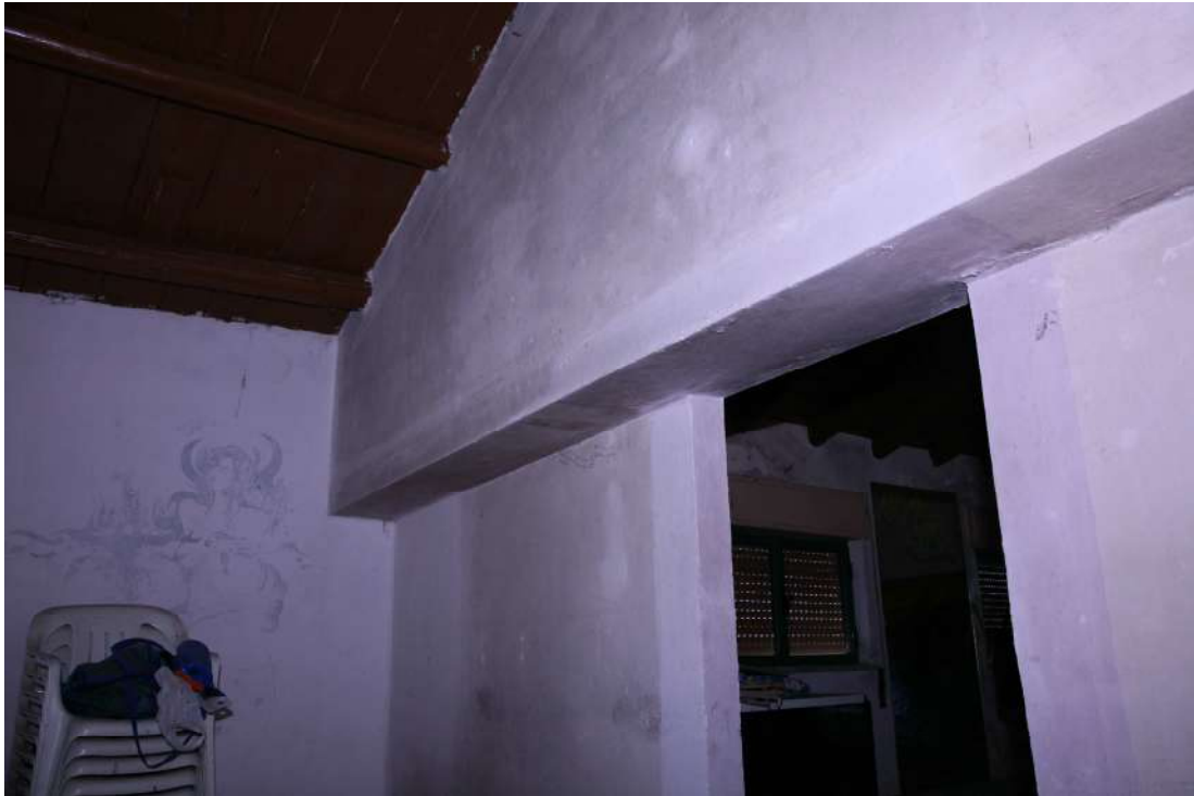
FOTO 23: Particolare trave in c.a. che poggia direttamente sul muro portante senza alcuna connessione con un cordolo in c.a.
