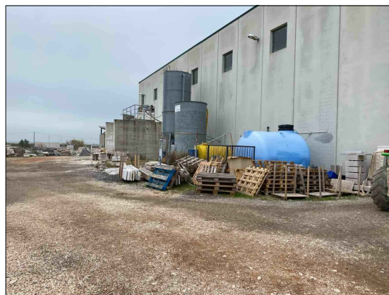
Cisterna per accumulo acqua potabile da 20.000 l e vasca di riciclaggio delle acque di lavorazione della pietra.
