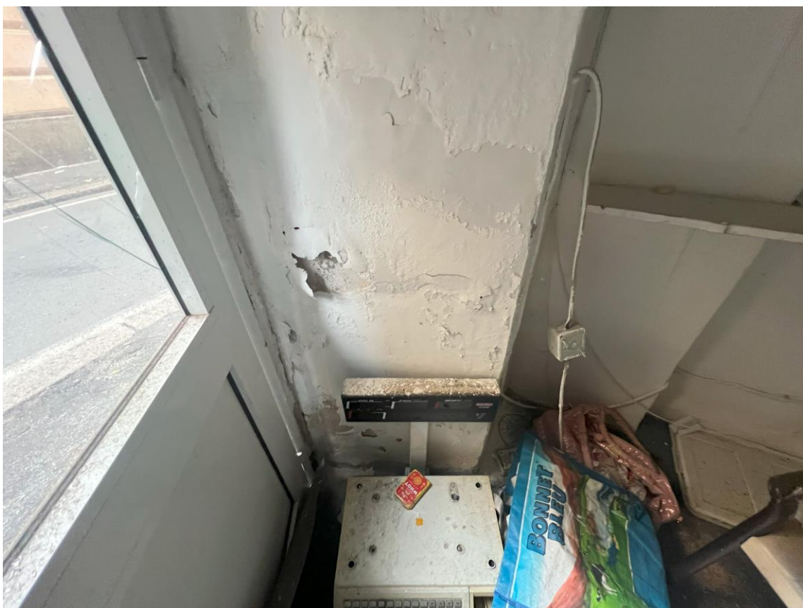
Foto 7. Particolare umidità muro perimetrale
