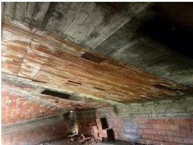
sottotetto infiltrazioni nel solaio copertura dovuto alla mancanza di impermeabilizzazione
