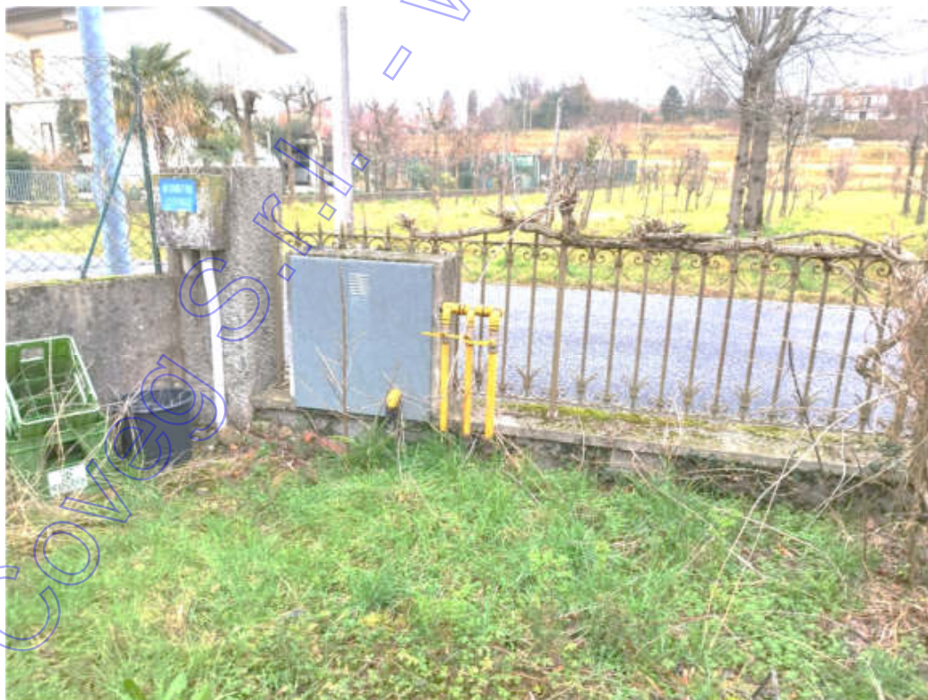
Particolare ingresso utenze (elettrica e gas) lato nord pc 275
