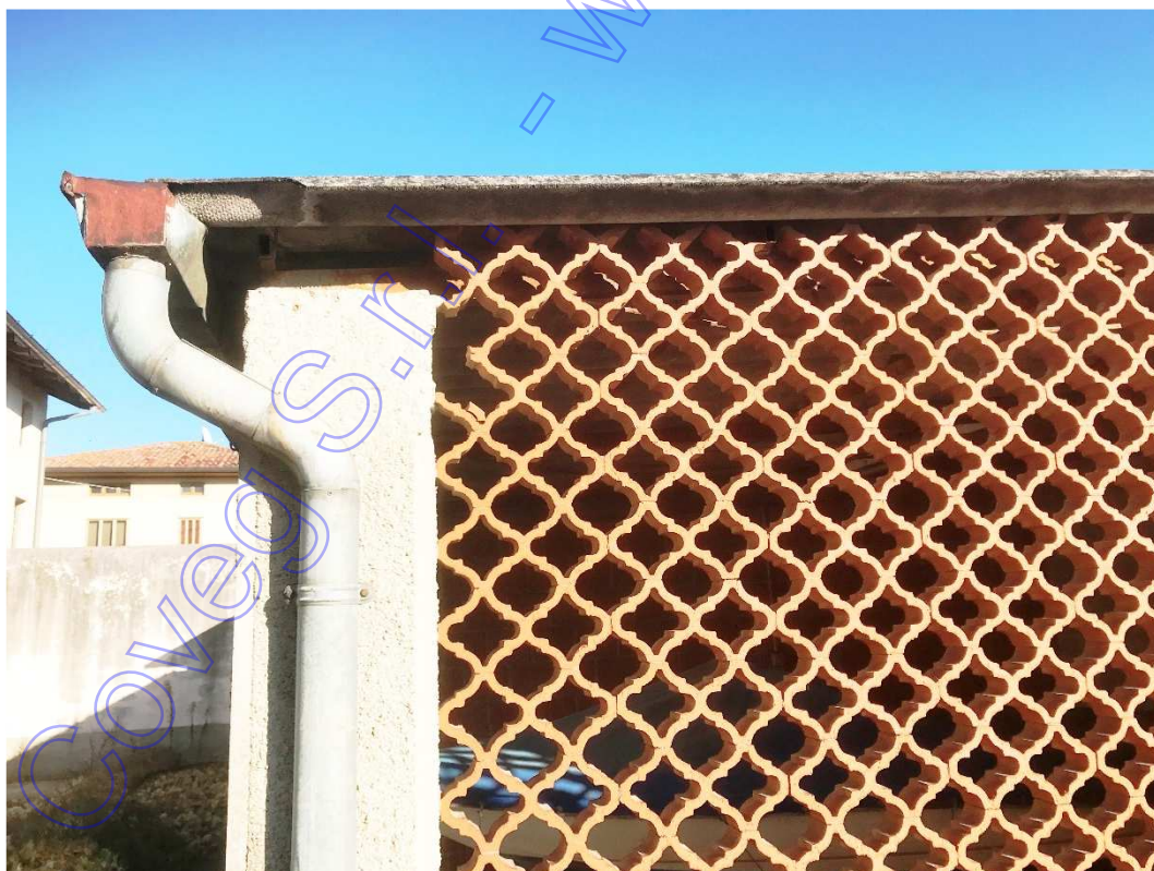
Particolare copertura in eternit della tettoia esterna
