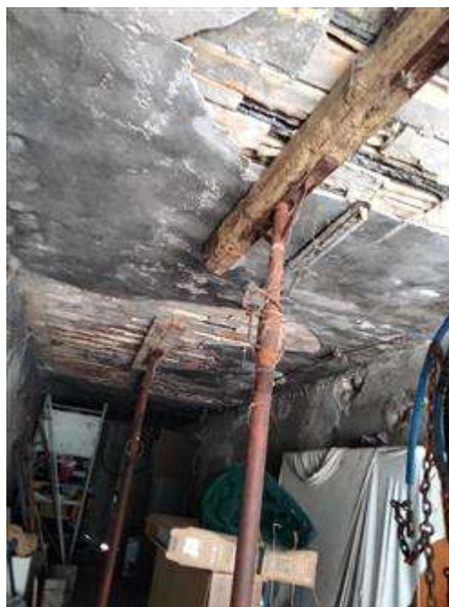
PARTICOLARE SEL SOLAIO PERICOLANTE
