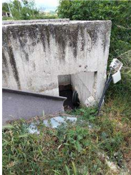
POZZETTO RACCOLTA LINEE REFLUI DEI TRE CAPANNONI
