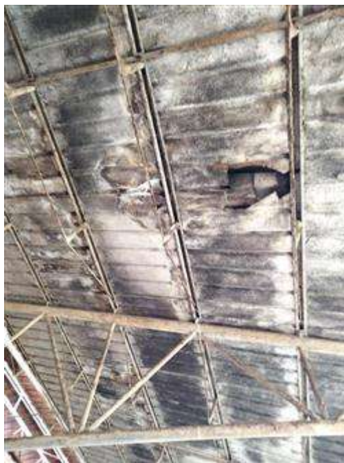
PARTICOLARE CEDIMENTO COPERTURA
