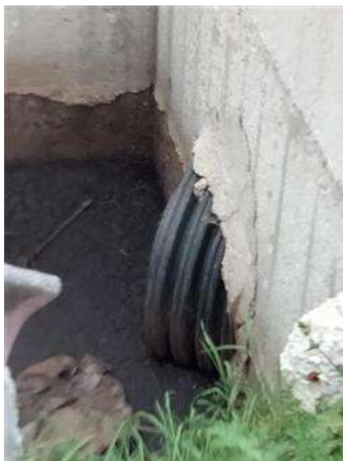
SISTEMA TRACIMAZIONE DEI POZZETTI
